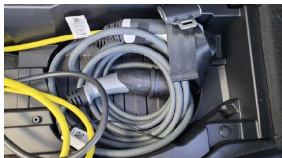
Fot. 28 Przewód ładowania baterii trakcyjnej
