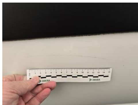
Fot. 40 Drzwi tylne P - Rysa/odprysk 1
